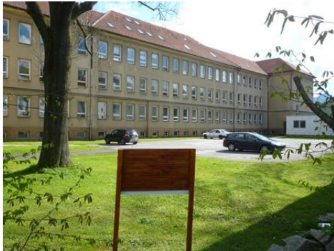
Primary School – Barvířská Street
