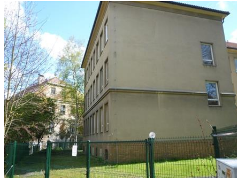
Primary School - Barvířská Street
